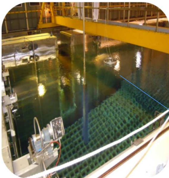
Postojeće mokro skladište
