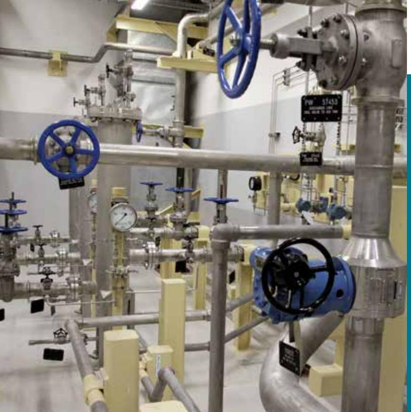
Jedno od ostalih tehnoloških unapređenja jest zamjena električnih aktuatora na ventilima sustava za kemijsku i volumnu kontrolu primarnog rashladnog medija. Također su u kondenzator ugrađene magnetske strukture za smanjivanje sadržaja čestica željeza u sekundarnom sustavu. Završena je i zadnja faza projekta navarivanja turbinskih veznih cjevovoda glavnih parovoda.
