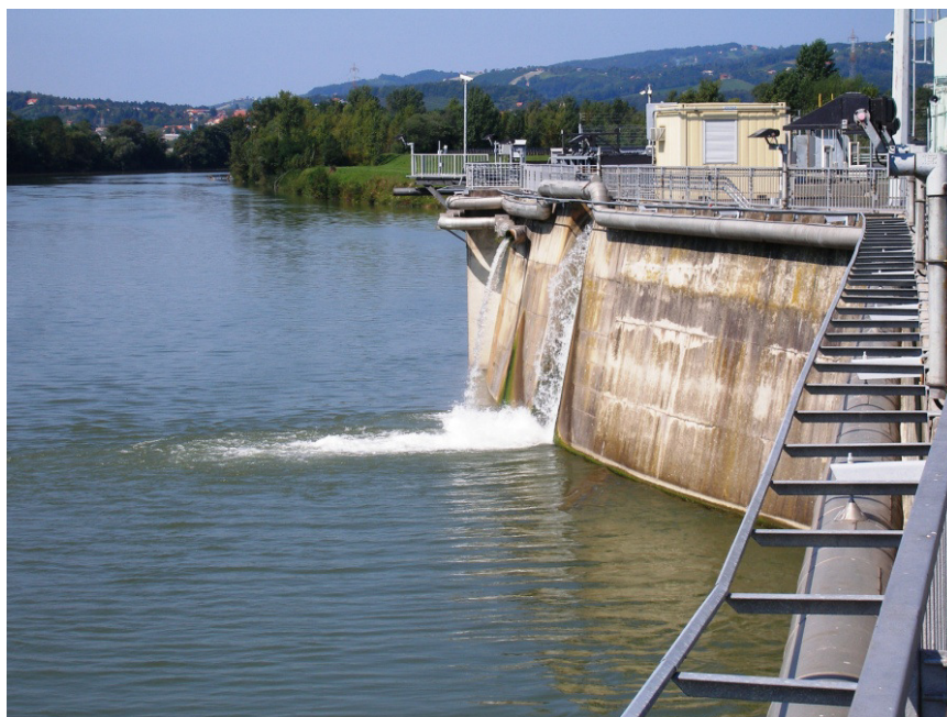
Slika 2.1: Izhod bistvene oskrbne vode (ESW), kjer se izpuščajo radioaktivne tekočine iz odpadnih merilnih rezervoarjev (WMT) in sistema za kaluženje uparjalnikov (SGBD). Fotografija je posneta z jeza.
