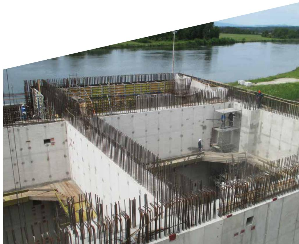
Zgrada BB2 koncipirana je tako da se u nju ugrade alternativni sustav sigurnosnog ubrizgavanja (ASI), alternativni sustav pomoćne napojne vode (AAF) i sigurnosno električno napajanje zgrade BB2. Pored zgrade BB2 predviđen je bunar za crpenje podzemne vode za dodatnu opskrbu alternativnih sustava sigurnosnog ubrizgavanja i električnog napajanja rashladnom vodom, također u slučaju povećanih projektnih zahtjeva.
