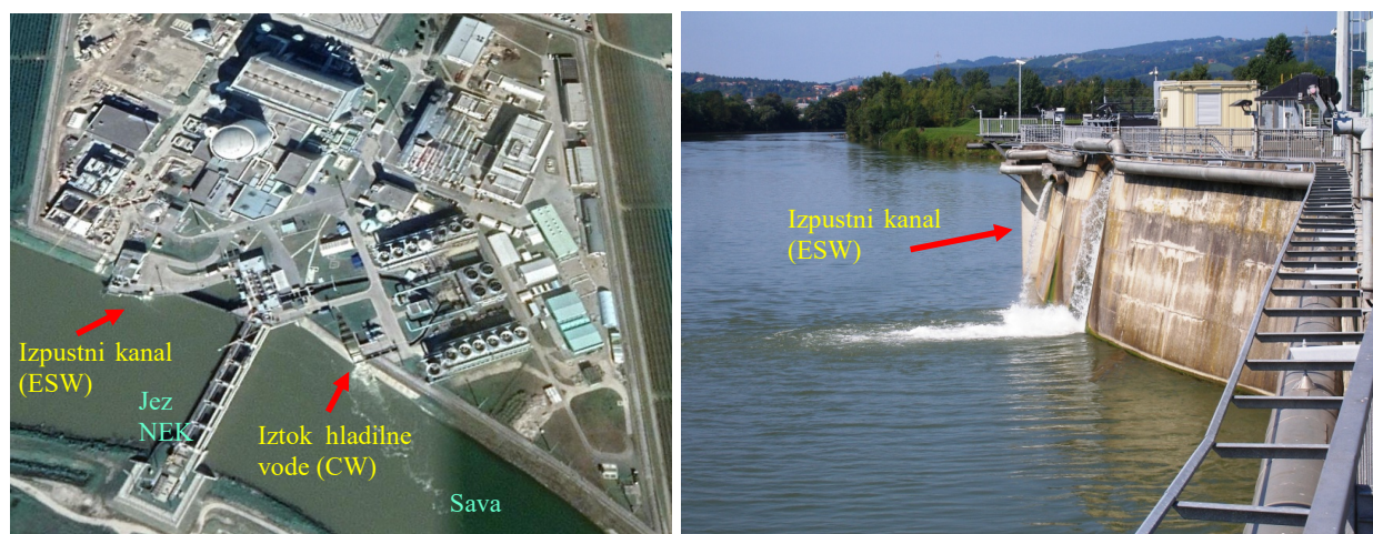
Slika 1.1: Izhod bistvene oskrbne vode (ESW), kjer se izpuščajo radioaktivne tekočine iz odpadnih merilnih rezervoarjev (WMT) in sistema za kaluženje uparjalnikov (SGBD). Fotografija na desni je posneta z jezja NEK.
